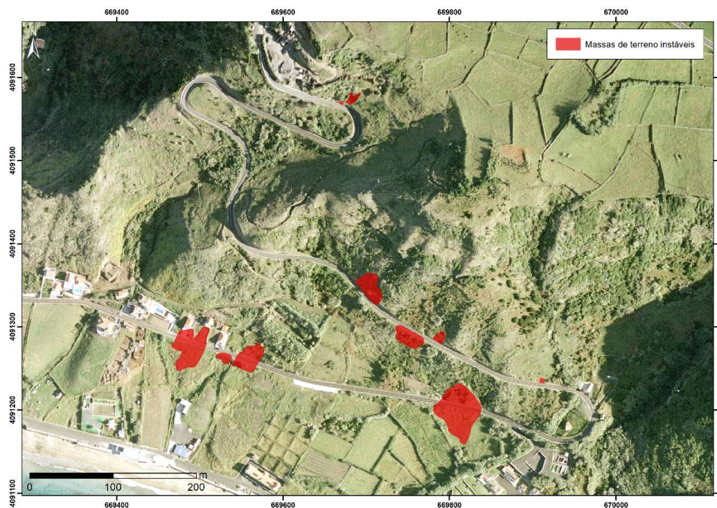
Figura 3 – Localização das massas de terreno instabilizadas na Praia Formosa, abrangidas pelas redes de monitorização.
